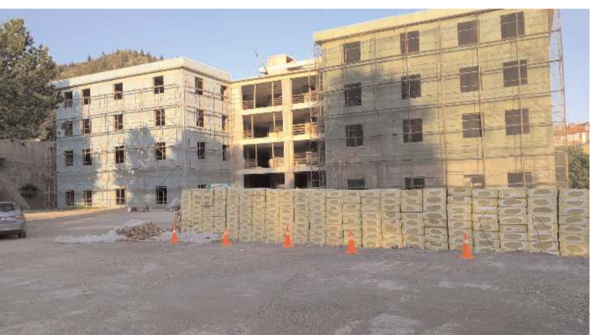
Binanın ikmal inşaatı için 24 Mayıs'ta yer teslimi yapılmıştı.
