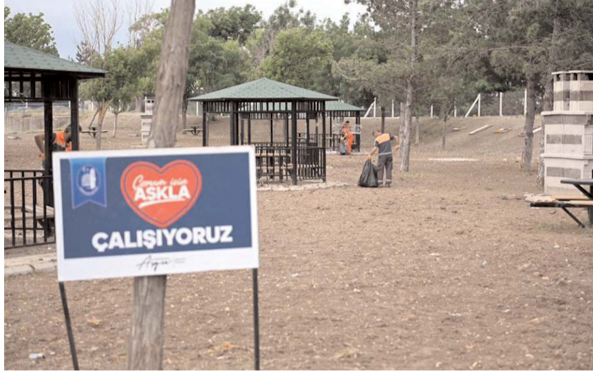
Çorum Belediyesi'nin Çomar Barajı mesire alanında çalışmalarını tamamlanmak üzere.
