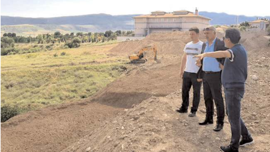
TOKİ Dodurga'da 3.etap konutların inşaatına başladı.
