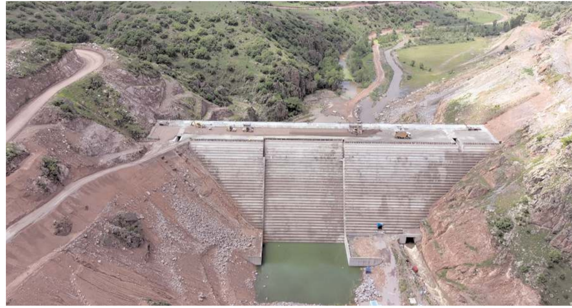
Kızlaryolu Barajı Çorum'da 24 bin 555 dekar alanı sulayacak.
