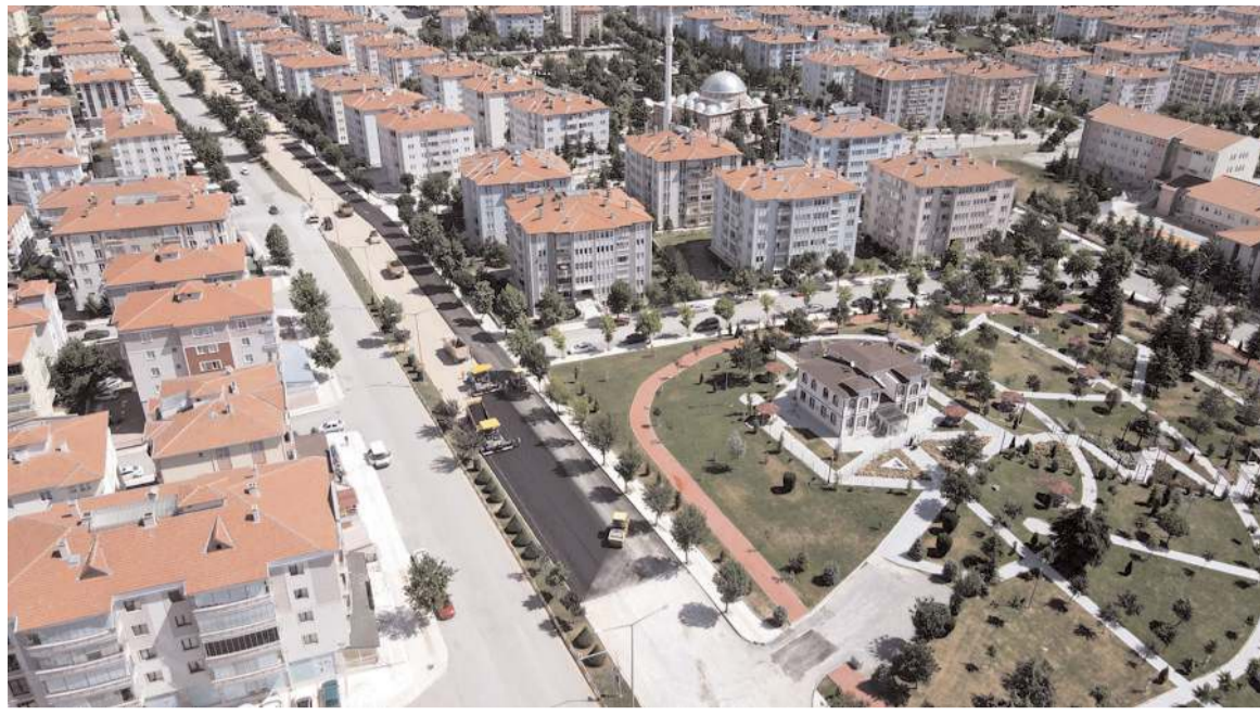
Bişkek Caddesi'nin 500 metrelik bölümünün asfaltı yenilendi.
