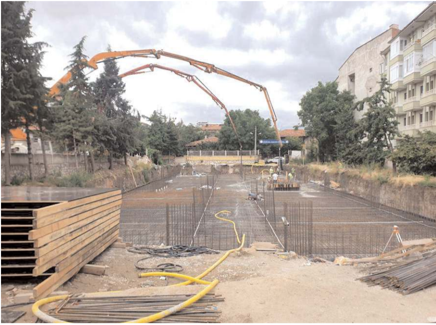
Kuran kursu binası Akşemseddin Camii arkasında yapılıyor.
