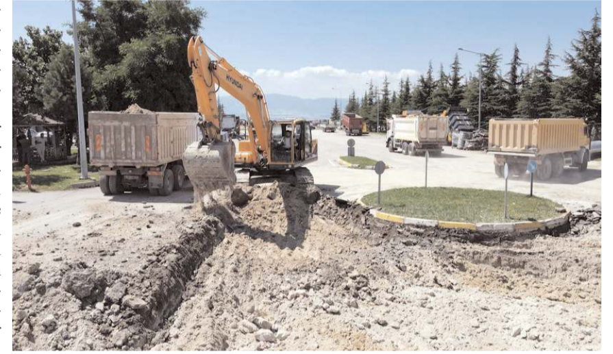
Yolun 180 metre uzunluk, 25 metre genişliğindeki kısmı yenileniyor.
