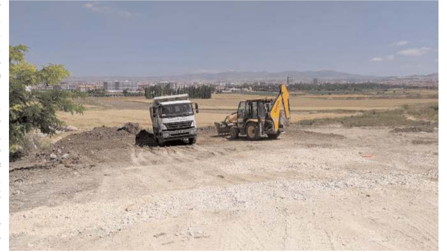
Mimar Sinan 9'uncu Cadde'de yol yapım çalışmaları devam ediyor.
