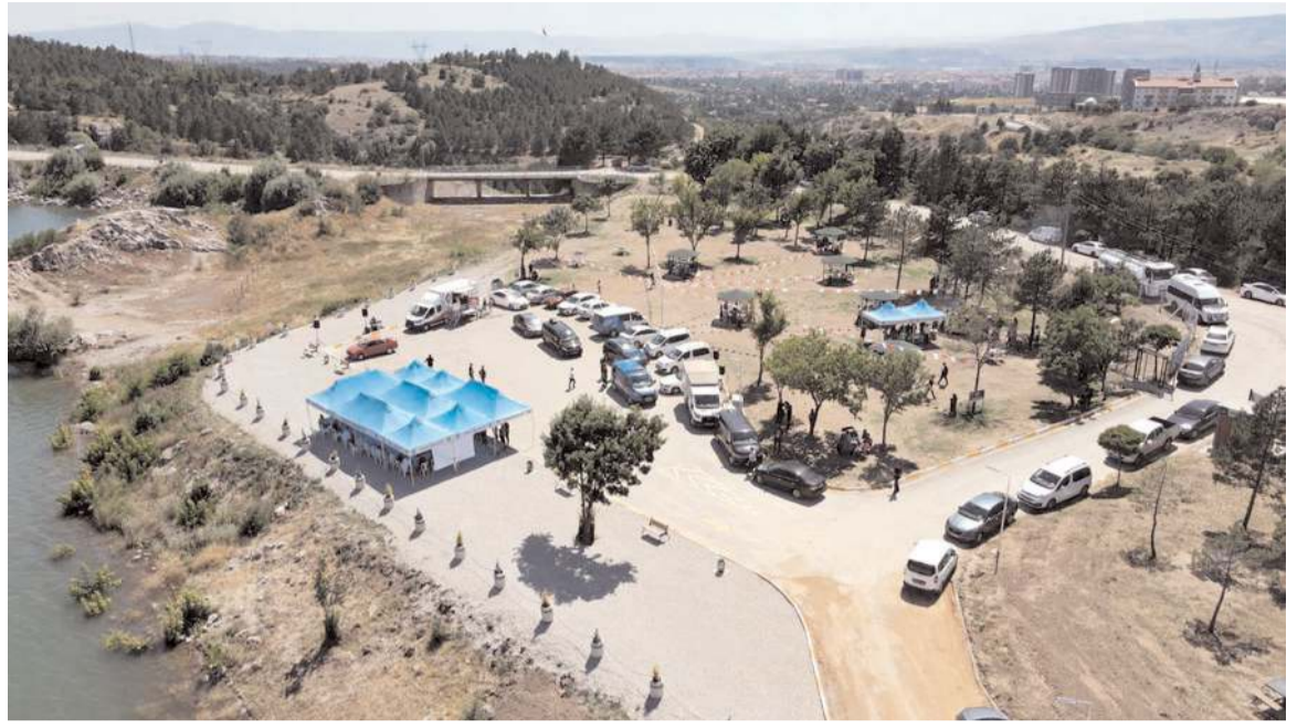
Çorum Belediyesi barajın bir kısmında çevre düzenlemesi yaptı.
