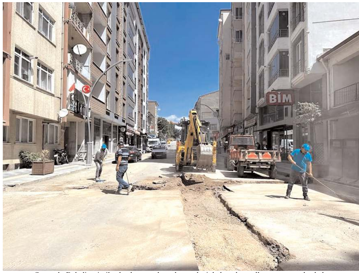
Sungurlu Belediyesi, ilçede altyapı çalışmaları nedeniyle bozulan yolları onarmaya başladı.
