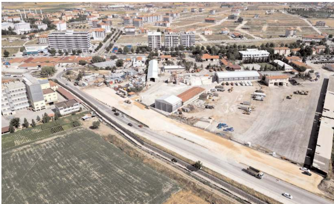
Yol tamamlandığında şehir merkezinin önemli bağlantı yollarından birisi olacak.
