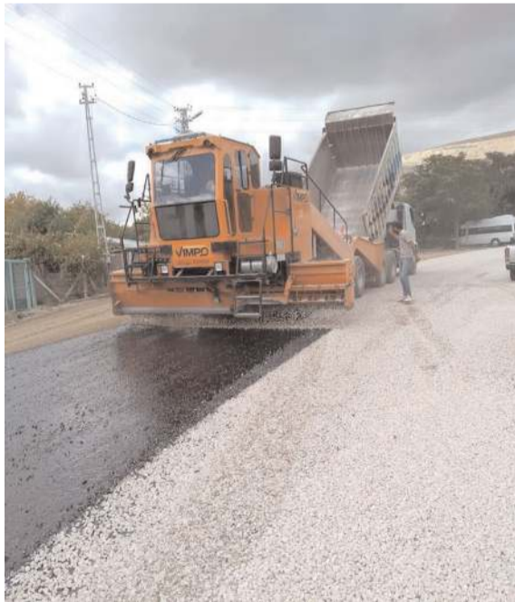
Belirli noktalarda genişletme çalışmaları yapılan 5 km'lik yola sıcak asfalt serildi.
