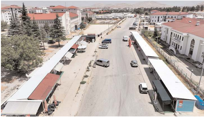
Depremle yıkılan ilçede esnaf faaliyetlerini konteynerlerde yürütüyor.
