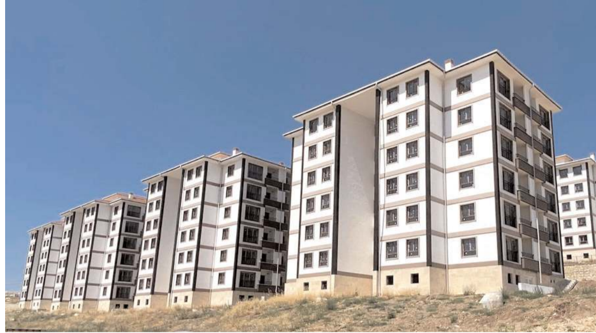
Silmkent TOKİ projesinde konutlar tamamlanırken çevre düzenlemesinin yapılması bekleniyor.
