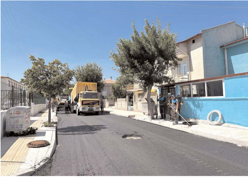
Gülabibey Mahallesi Beytepe Sokakların asfaltı yenildi.
