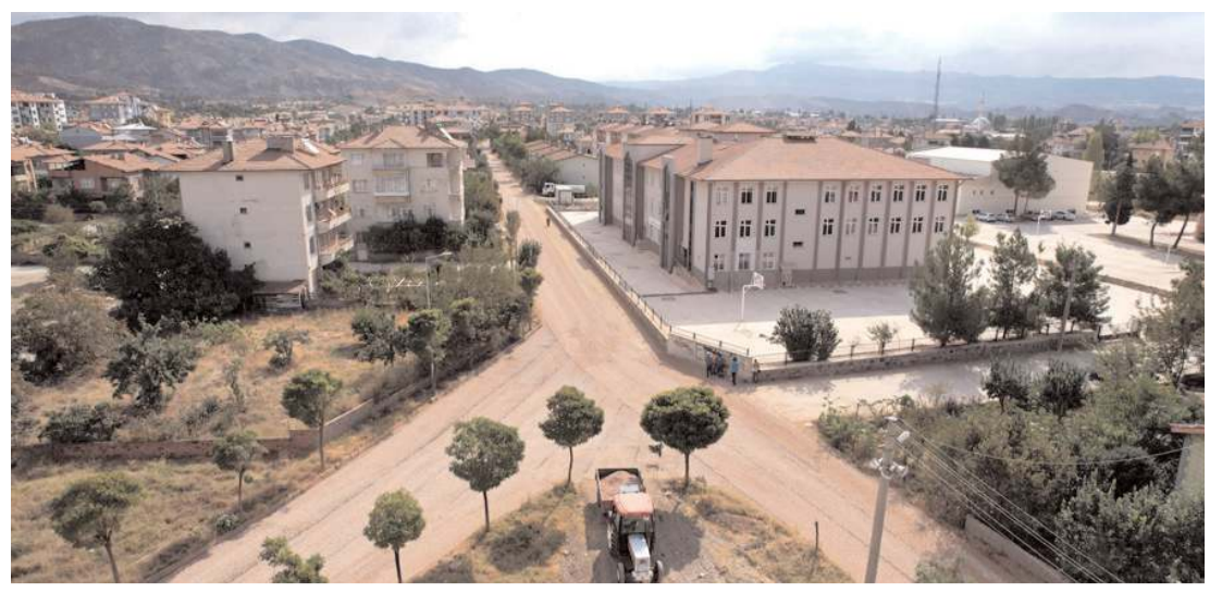
İlçede altyapı çalışmaları nedeniyle bozulan yollar tekrar asfaltlandı.
