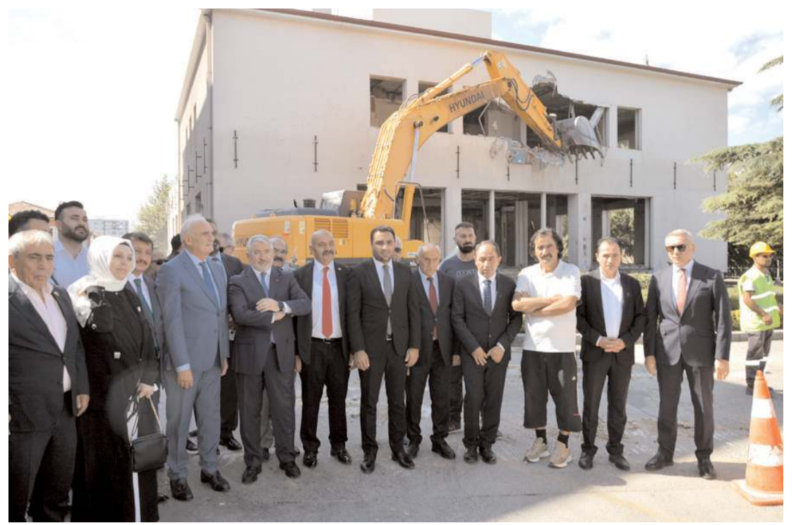
Tarihi Şehir Meydanı projesi kapsamında Ziraat Bankası'nın yıkımı dün gerçekleştirildi.
