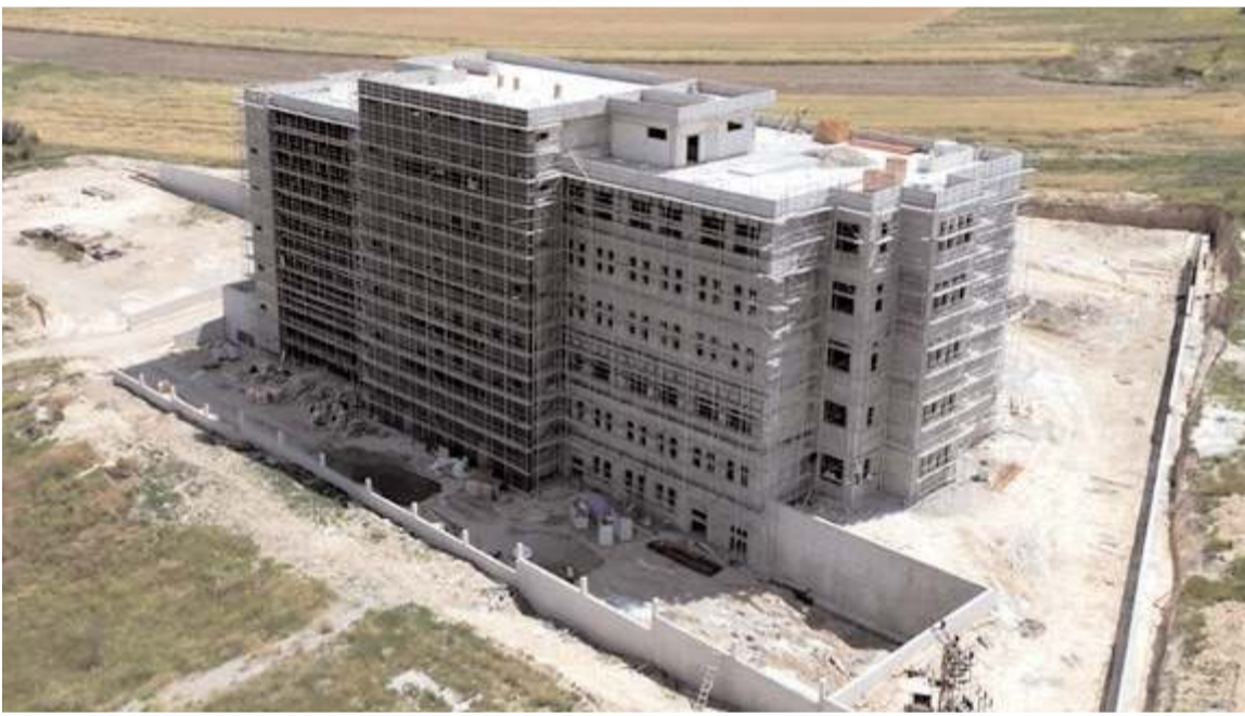
Şehidin yakınları isminin inşaatı bitmek üzere olan Diş Hastanesine verilmesini istiyor.
