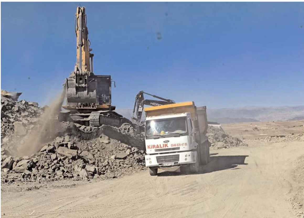
Proje kapsamında 35 km uzunluğunda beton kanal yapılacak.
