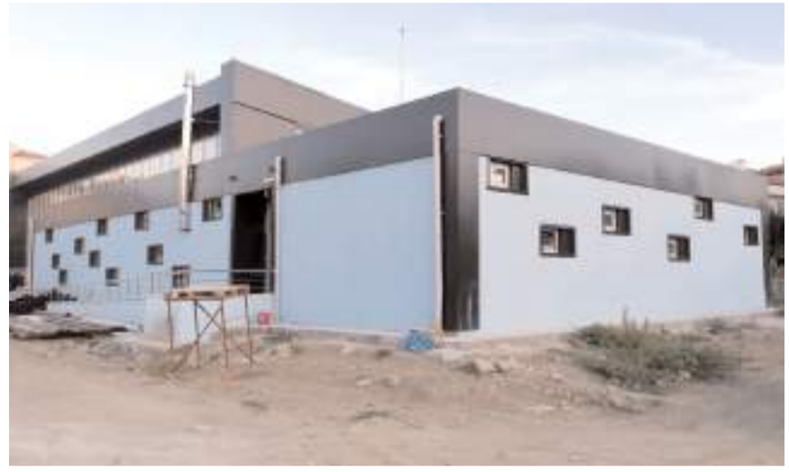
Yarı Olimpik Yüzme Havuzu inşaatı % 90 oranında tamamlandı ve hizmete açılmayı bekliyor
