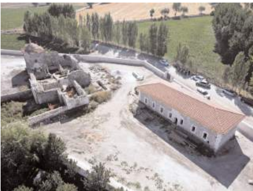
Hüseyin Gazi Külliyesi'nde restorasyon çalışmaları devam ediyor.
