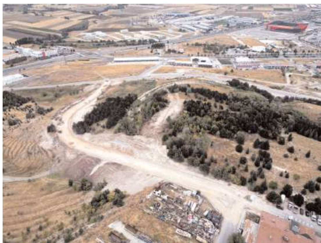
Yolda bordür çalışmalarının ardından asfalt serilecek.
