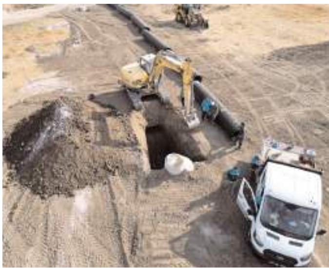
Yağmur suyu hattı çalışmalarında sona yaklaşıldı.
