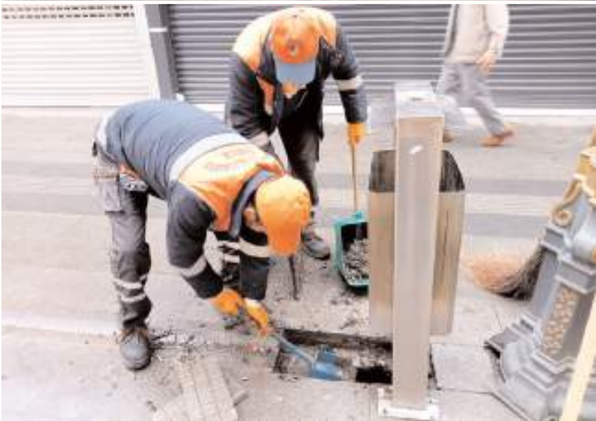
Ekipler tıkalı mazgalları açıyor.
