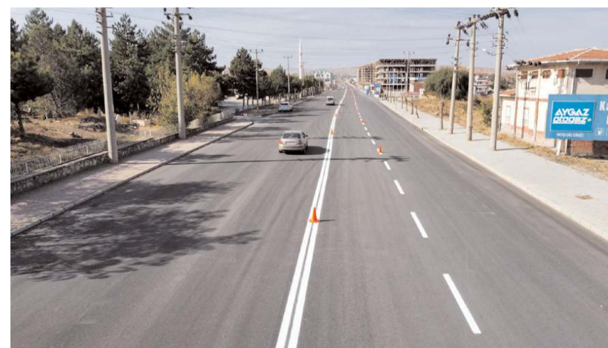
Çorum yolu olarak bilinen bölgede 2 bin 500 metrelik sıcak asfalt serimi yapıldı.
