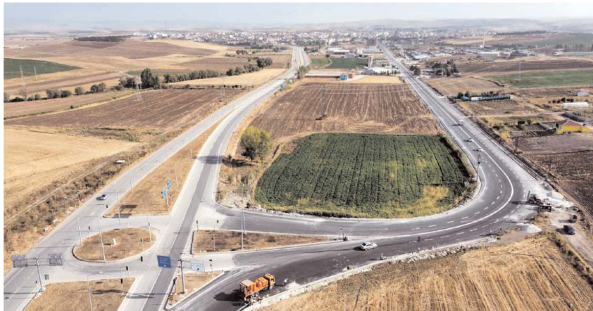
Çizgi çalışmalarının ardından yol çalışmaları sona erdi.
