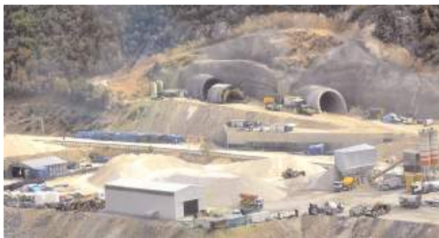
10 kilometrelik yola 1389, 1157 ve 1553 metre uzunluğunda 3 tünel, 3 hemzemin kavşak ve 2 alt geçit yapılıyor.
