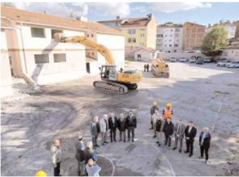
Okulun yıkım çalışmaları başladı.
