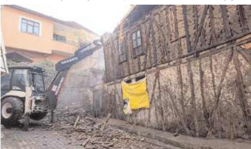
Çeşme Mahallesi'ndeki bir metruk evin yıkımına başlandı.
