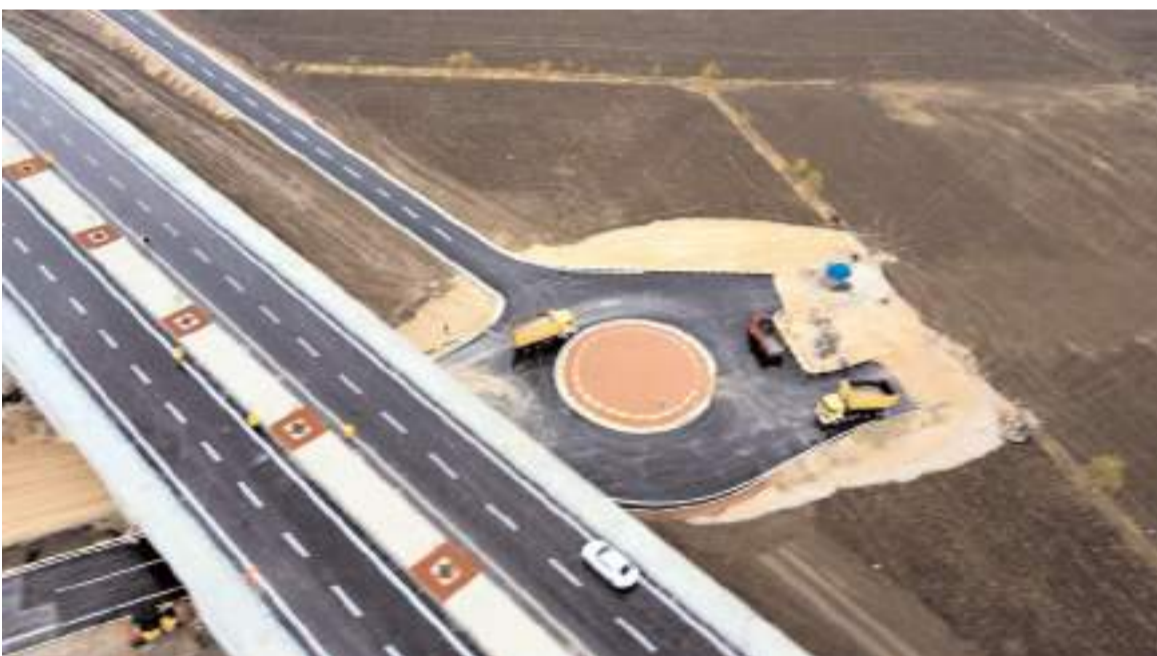
Çorum Belediyesi ekipleri yeni İskilip yolunun Akşemseddin Kavşağı bağlantısında asfalt çalışmalarını tamamladı.
