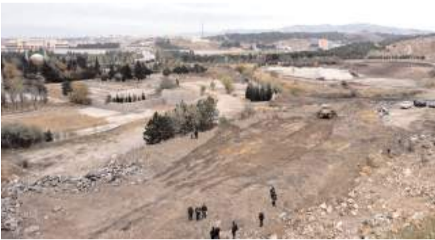
2300 metre uzunluğundaki yol 35 metre genişliğinde olacak.
