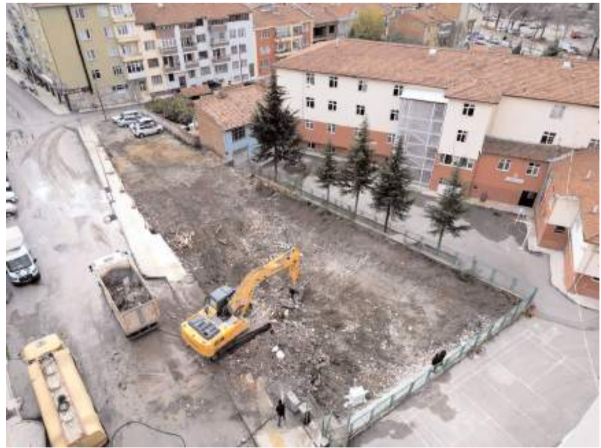
Çorum Belediyesi Erol Olçok İmam Hatip Lisesi bitişiğindeki atıl binayı yıktı.
