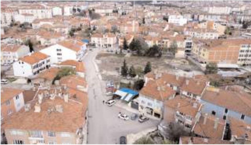
Tanyeri İlkokulu binası geçtiğimiz günlerde yıkılmıştı.
