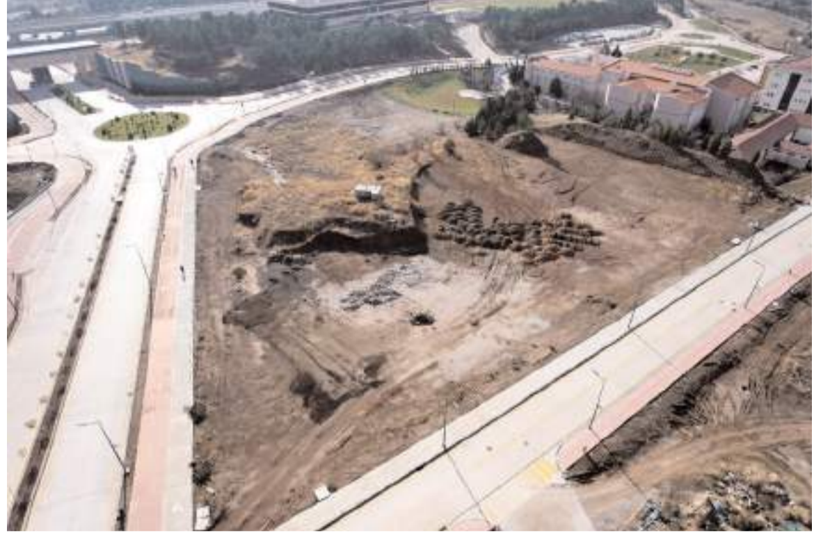
Caminin temel kazısı 2019 yılında yapılmıştı.
