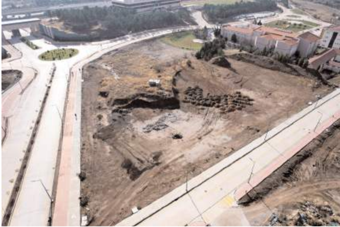
Caminin temel kazısı 2019 yılında yapılmıştı.
