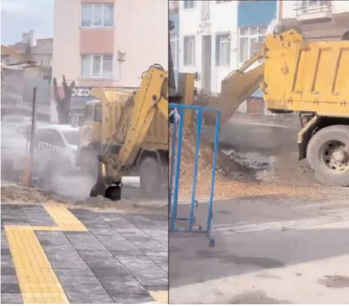
Patlayan borunun onarımı için ekipler uzun süre çalışma yaptı.
