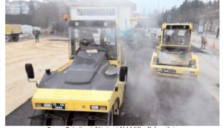
Çorum Belediyesi, Yüzüncü Yıl Millet Bahçesi'nin etrafında asfaltlama çalışması başladı.
