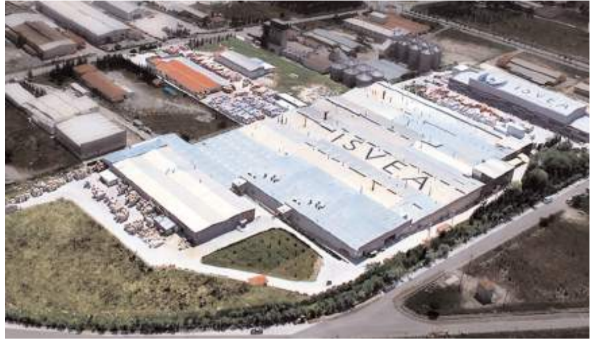
Isvea Çorum OSB'de bulunan fabrikada üretim yapıyor.
