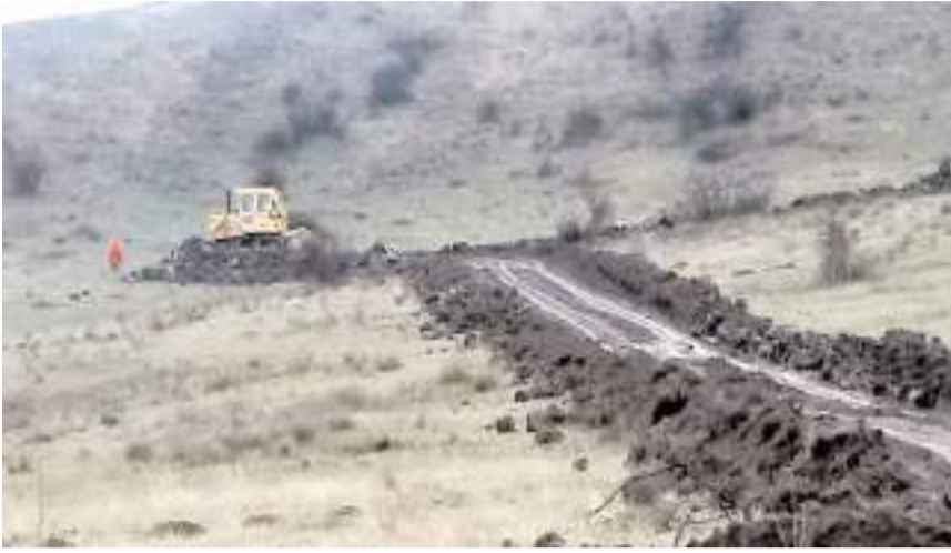
İl Özel İdaresi iş makineleri sondaj çalışmaları için yol açıyor.
