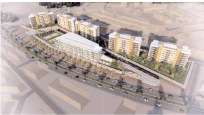
AHL Park Elazığ projesi, 108.500 m2'lik bir inşaat alanını kapsayacak.
