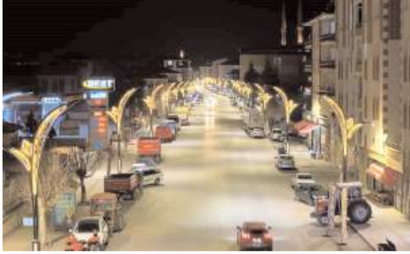
Caddelere 171 adet led aydınlatma monte edildi.
