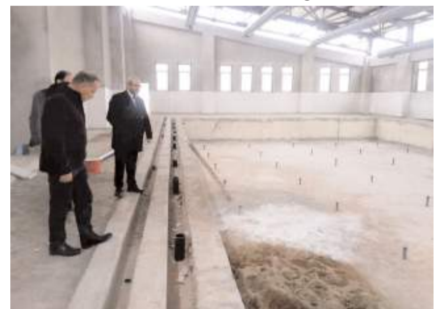
Cemil Çağlar yapımı devam eden Yüzme Havuzu inşaatında incelemelerde bulundu
