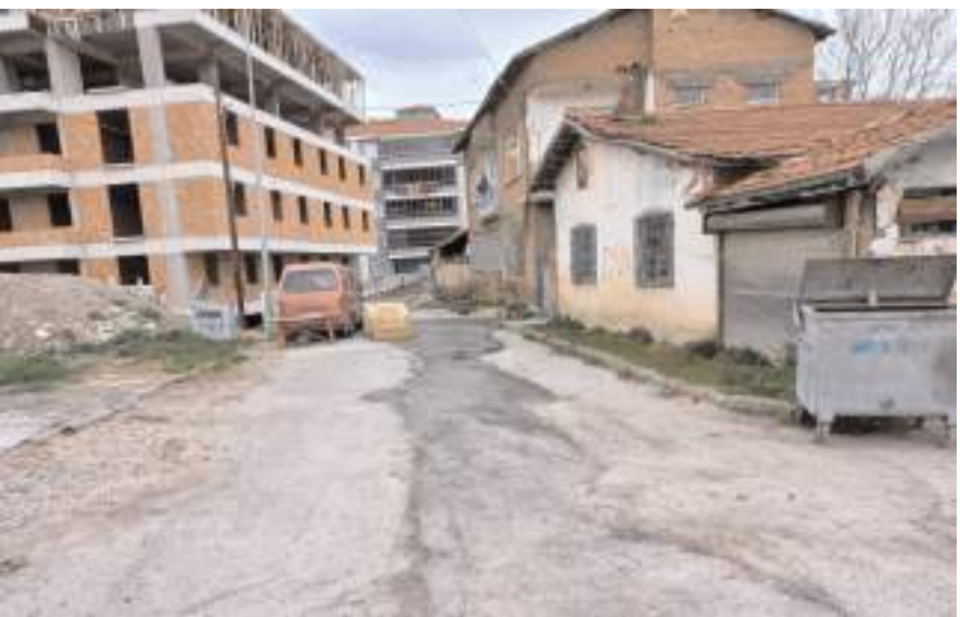
Camiye giden yoldan bir tanesi inşaat sahasında kaldığı için kullanılmıyor.
