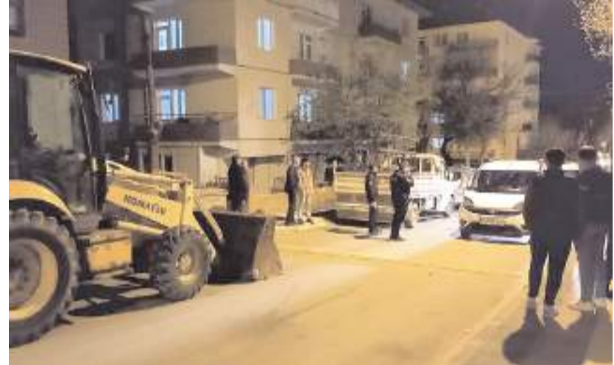
Olay Gülabibey Mahallesi Vatan Caddesi üzerinde bir binada meydana geldi.
