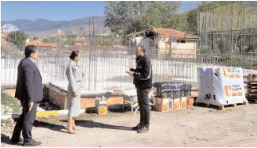
Laçın Kaymakamı Yağmur Şimşek, inşaatı inceleme de bulundu.
