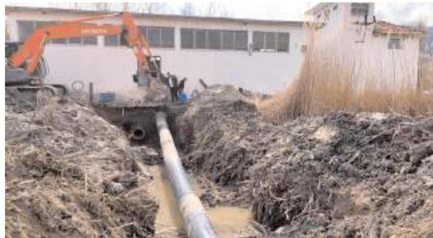
Yeşilköy-Dereköy-Çakırlar köyleri mevcut pompaj tesisini yenileme projesi tamamlandı.
