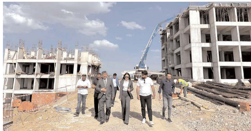
Laçın Kaymakamı Yağmur Şimşek, inşaat çalışmalarını inceledi.
