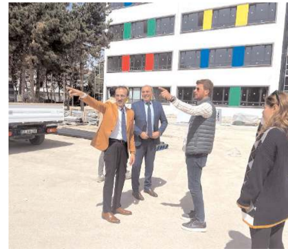
İl Millî Eğitim Müdürü Abdullah Kodek, yeniden yapılan Atatürk İlkokulu inşaatının son durumu hakkında bilgi aldı.
