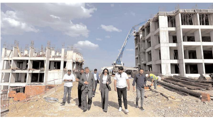
Laçın Kaymakamı Yağmur Şimşek, inşaat çalışmalarını inceledi.
