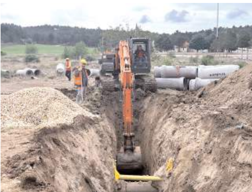
Bölgede alt yapı çalışmaları başladı.
