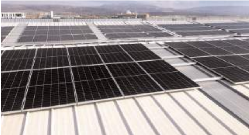
Güneş Enerjisi Santrali fabrika çatısına kuruldu.
