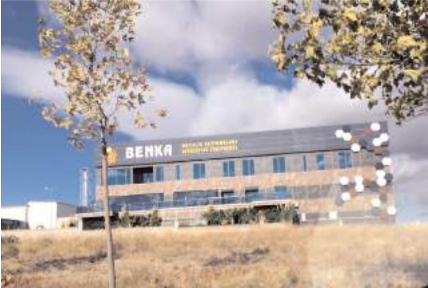
Benka Arıcılık Güneş Enerjisi Santrali Kurulum Projesini tamamladı.
