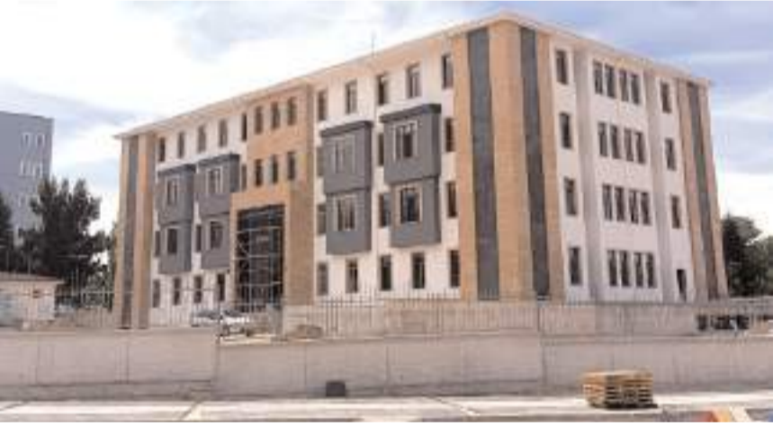
Çevre ve Şehircilik İl Müdürlüğü yeni hizmet binası Tuzcular Kavşağında inşaa edildi.
