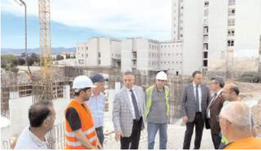
Milletvekili Mehmet Tahtasız, hastane inşaatında inceleme yapıyor.
