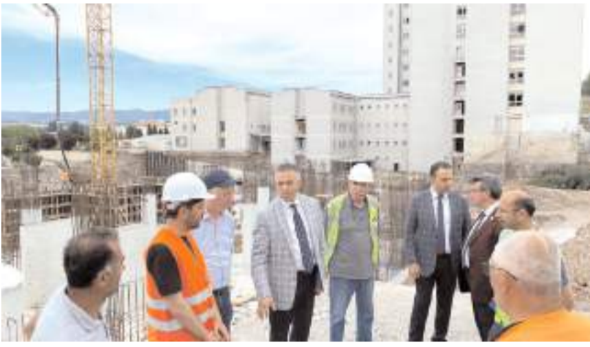
Milletvekili Mehmet Tahtasız, hastane inşaatı hakkında yetkililerden bilgi aldı.
