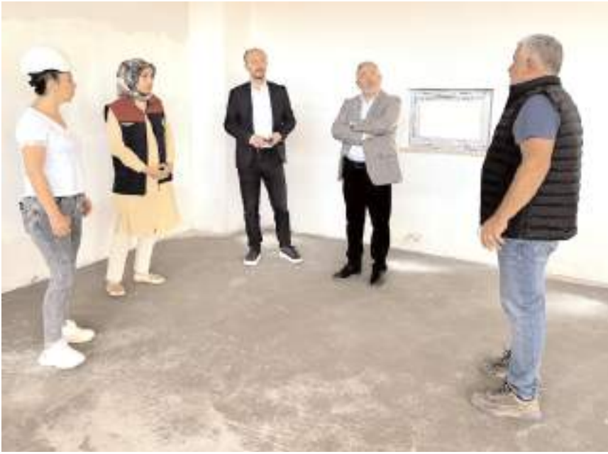
Dr. Halil İbrahim Aşgın masa tenisi salon inşaatında incelemelerde bulundu
