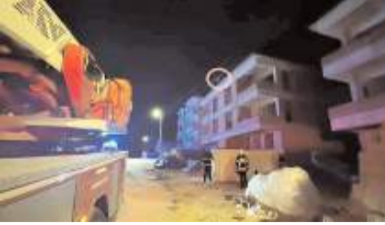
Olay Bahçelievler Mahallesi Sülükteveler 40. Sokak'ta bulunan inşaat meydanı geldi.
