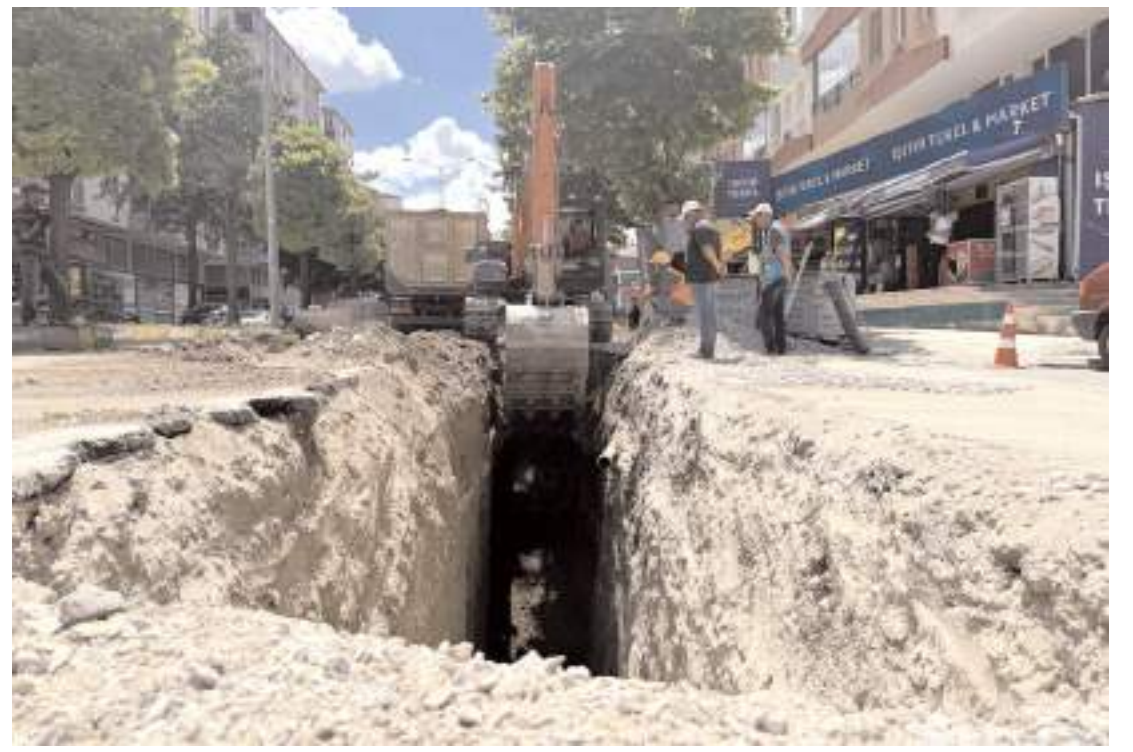
200 metre uzunluğunda 600 mm çapında yağmur suyu hattı yapılacak.
