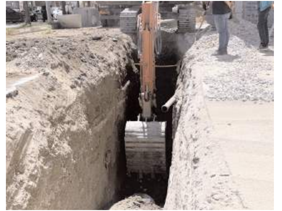
Bahabey Caddesi'nde altyapı yenileme çalışmaları başlatıldı.
