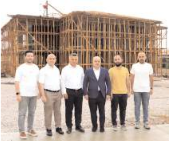
Vali Doç. Dr. Zülkif Dağlı, yapımı devam eden cami inşaatında incelemelerde bulundu.
