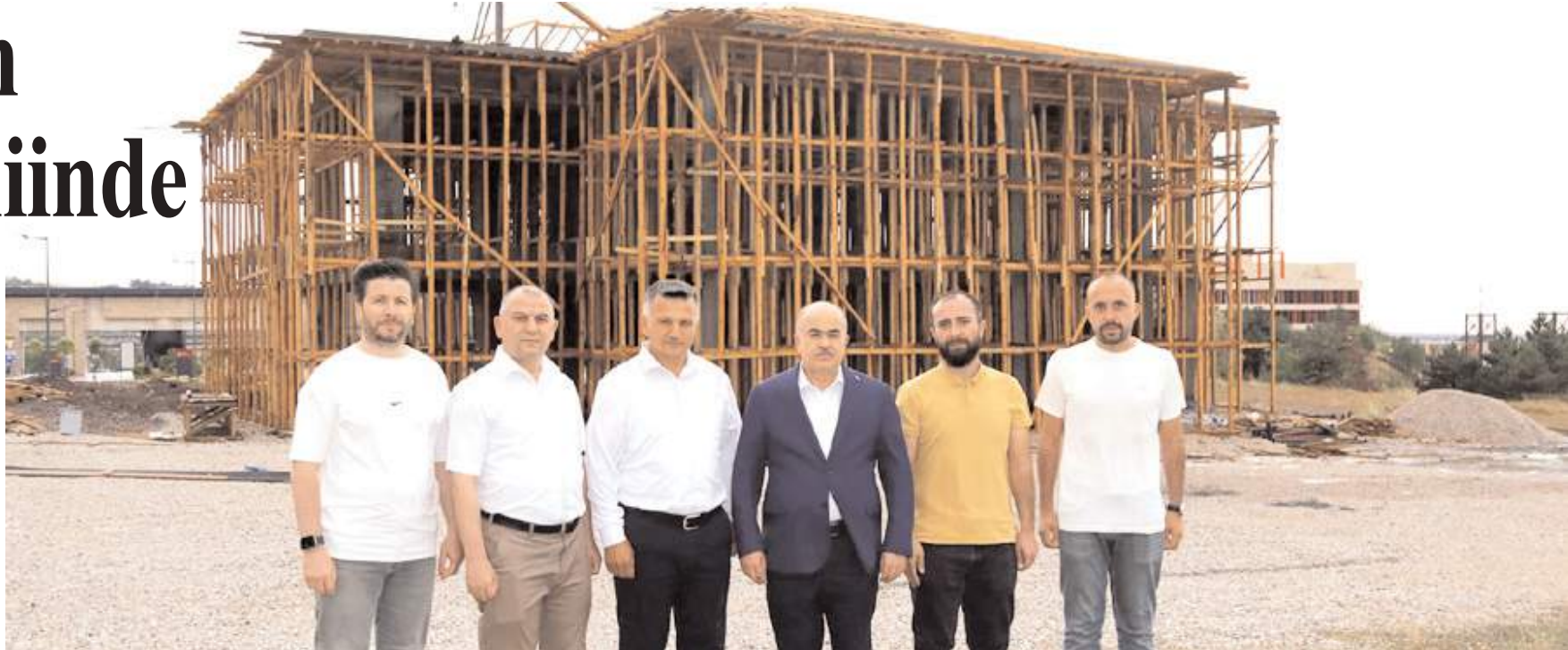
Vali Doç. Dr. Zülkif Dağlı, yapımı devam eden cami inşaatında incelemelerde bulundu.
