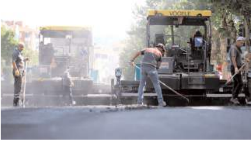
Çorum Belediyesi, şehrin önemli caddelerinde asfalt yenileme çalışmaları yapıyor.
