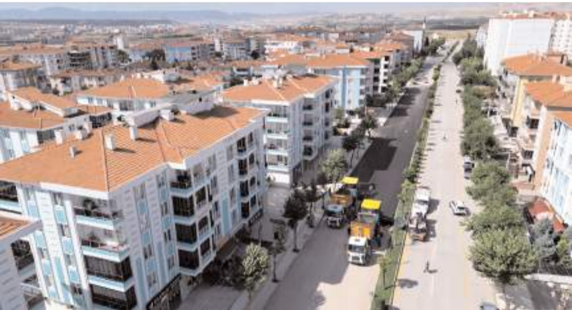
Adnan Özejder Caddesinde 270 metre uzunluğunda alanda asfalt yenileniyor.
