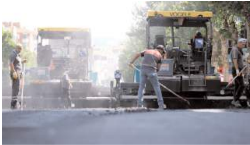
Çorum Belediyesi, şehrin önemli caddelerinde asfalt yenileme çalışmaları yapıyor.
