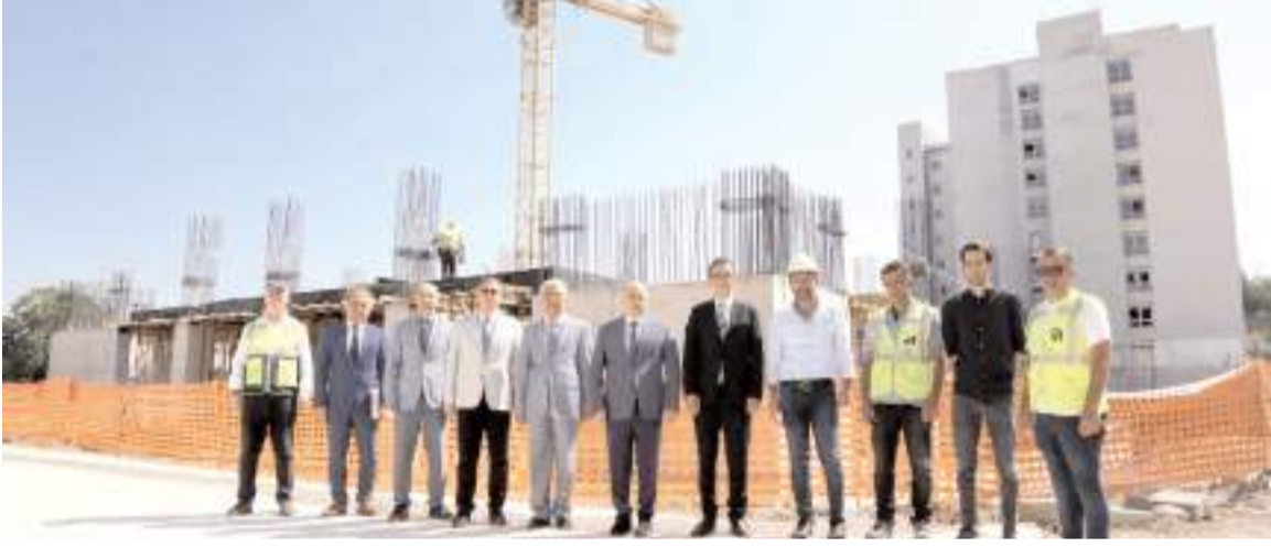
Vali Dağlı hastane inşaatında incelemelerde bulundu.
