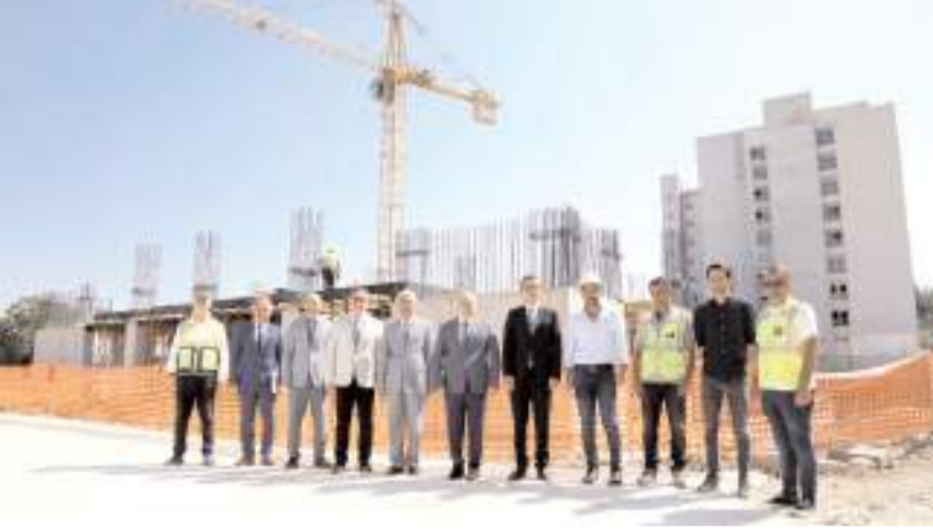
Vali Dağlı hastane inşaatında incelemelerde bulundu.
