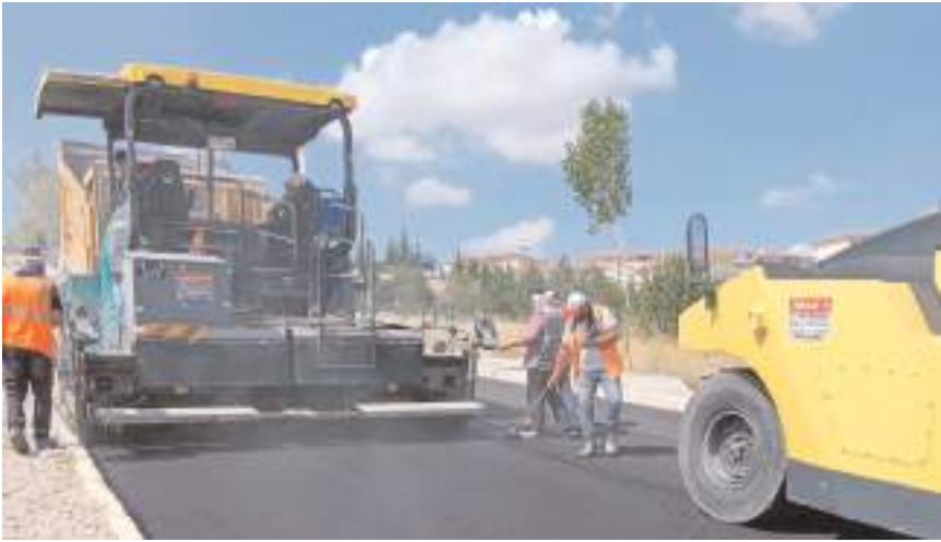
Yolun alt yapısı tamamen yenilendi.
