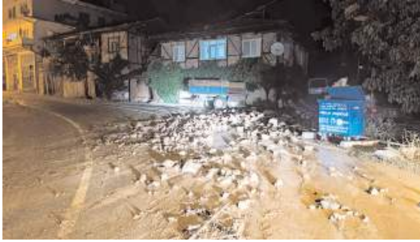
Yağış nedeniyle bazı evlerin bahçe duvarları ve çatıları yıkıldı.
