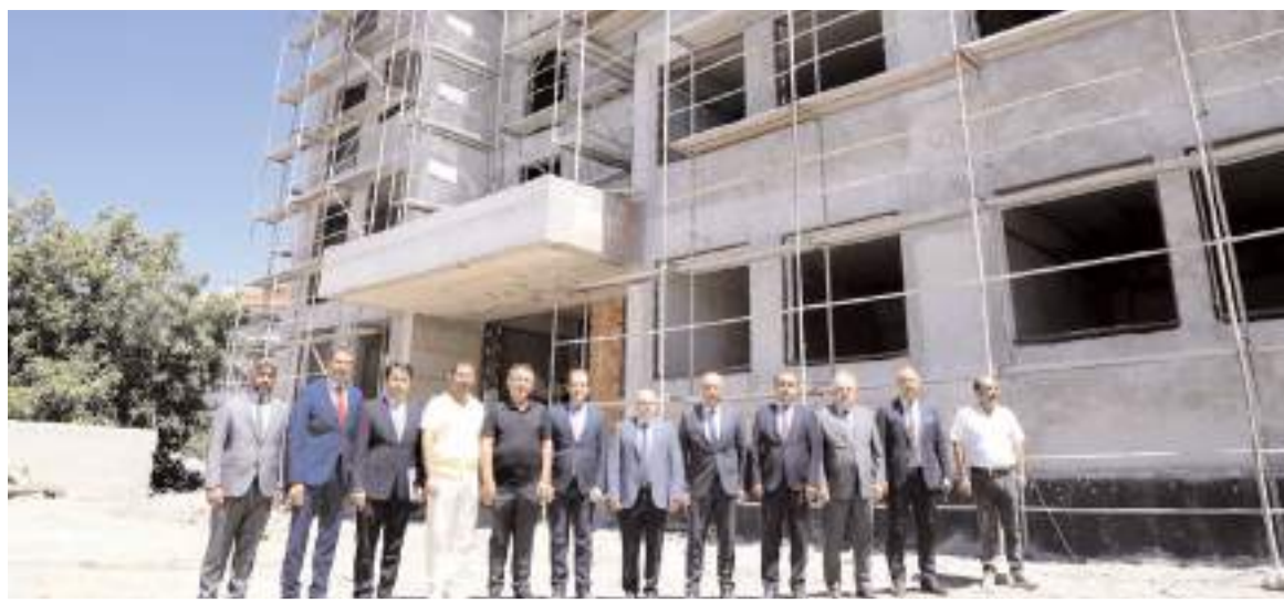
Vali Doç Dr.Zülkif Dađlı, okul inşaatında incelemelerde bulunmuştu.
